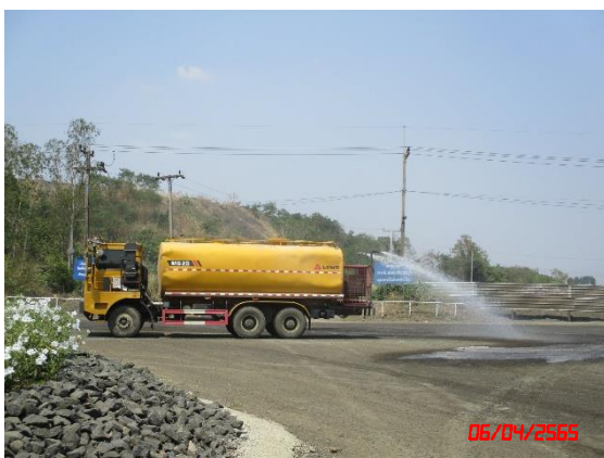
รูปที่ 2-7 การฉีดพรมน้ำเพื่อลดการฟุ้งกระจายของฝุ่นละออง
