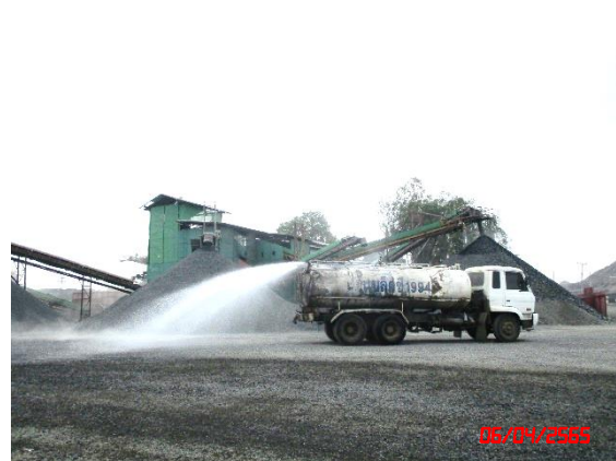
รูปที่ 2-7 การฉีดพรมน้ำเพื่อลดการฟุ้งกระจายของฝุ่นละออง
